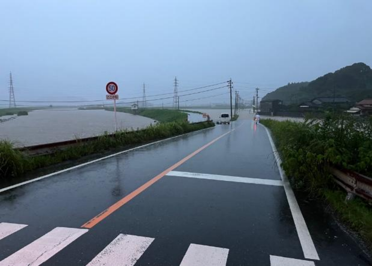
令和 5 年 7 月 大雨時（漆生・黒田）
