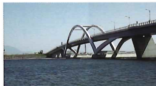
海の中道大橋(福岡市東区)
