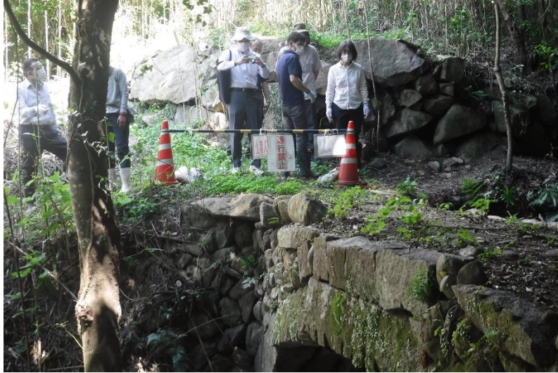
①桑野地区リブアーチ型石橋視察状況
