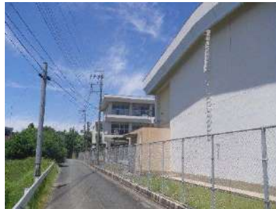
④西側道路と住宅地側ガード レール。ネットフェンスと 稲築東中学校
