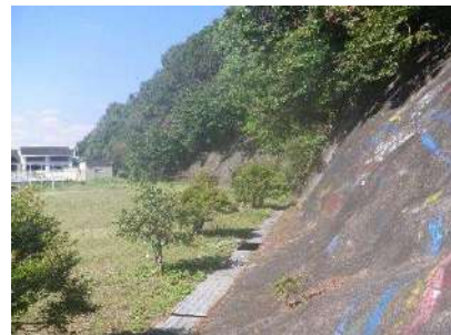
⑥東側間知ブロック積擁壁と モルタル吹付の法面
