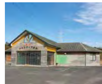
バスステーション改修予定地
