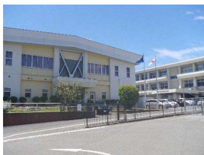
①正門の明るいアプローチと 体育館
