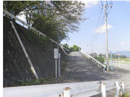
② 北側既存擁壁と桜並木
