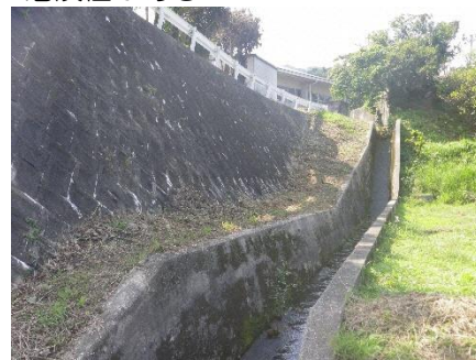
⑥ 西側間知石積の擁壁
