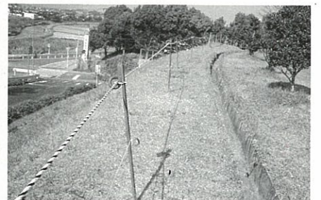
確井小学校防護柵
