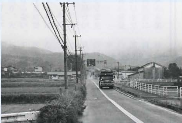
国道322号（千手地区）
