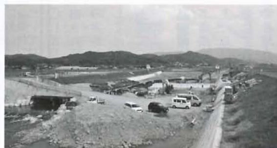
戸倉・柳原堰災害復旧事業（約3億円）
