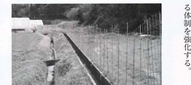
設置された防護柵
