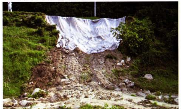
災害復旧工事予定地(泉河内)
