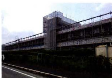
工事が進む牛限小学校
