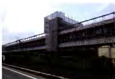
工事が進む牛限小学校
