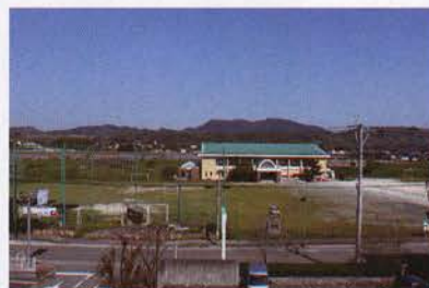
新庁舎建設予定地
