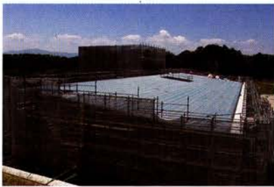
建設が進む嘉麻斎場
