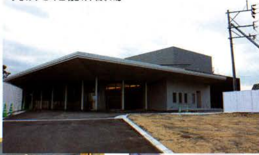
完成した嘉麻斎場
