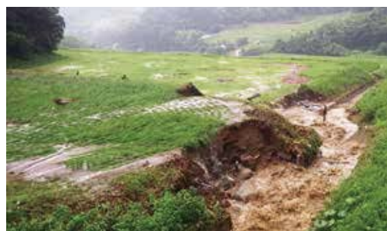
九州北部豪雨での災害箇所
