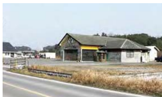
（仮称）総合バスステーション建設予定地 （フロンティア嘉穂跡地）
