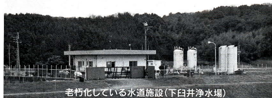
老朽化している水道施設(下臼井浄水場)
