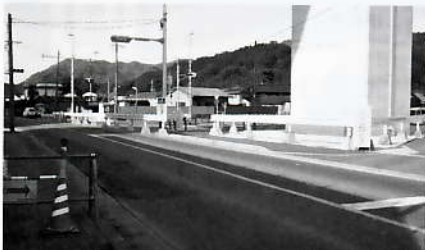
道路改良がなされている下山田地区
