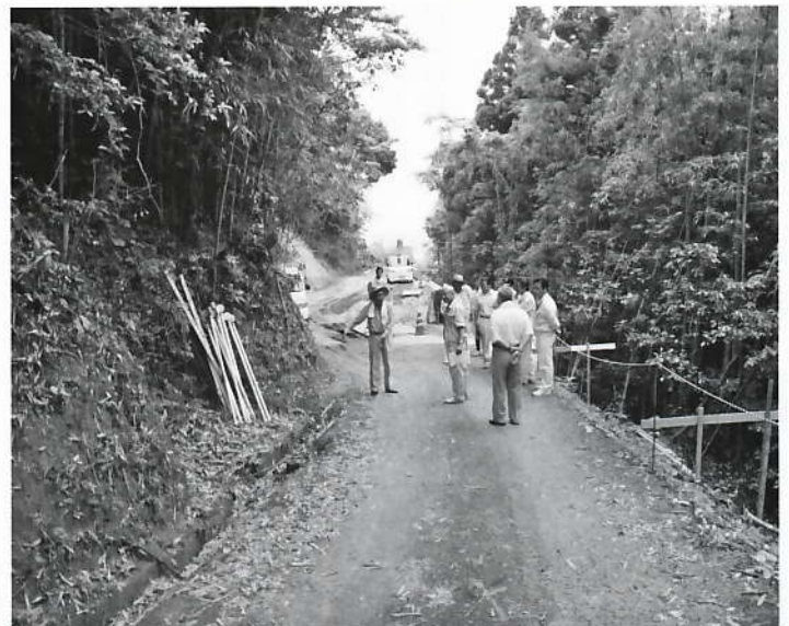
益富城自然公園の道路拡幅工事を視察する委員
