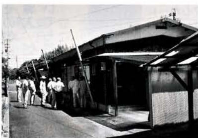
老朽化した市営住宅
