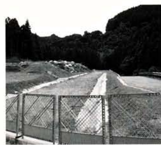
国道322号大力付近
