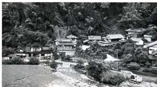
桑野地区の土砂災害（7月）
