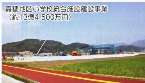
建設が進む嘉穂小学校
