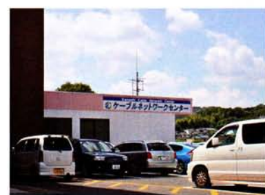
ケーブルネットワークセンター
