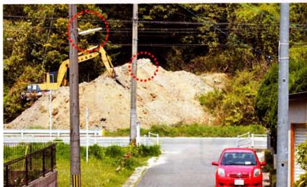
LED化が進められる外灯
