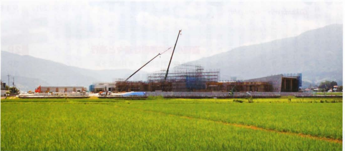
工事が進む嘉穂小学校
