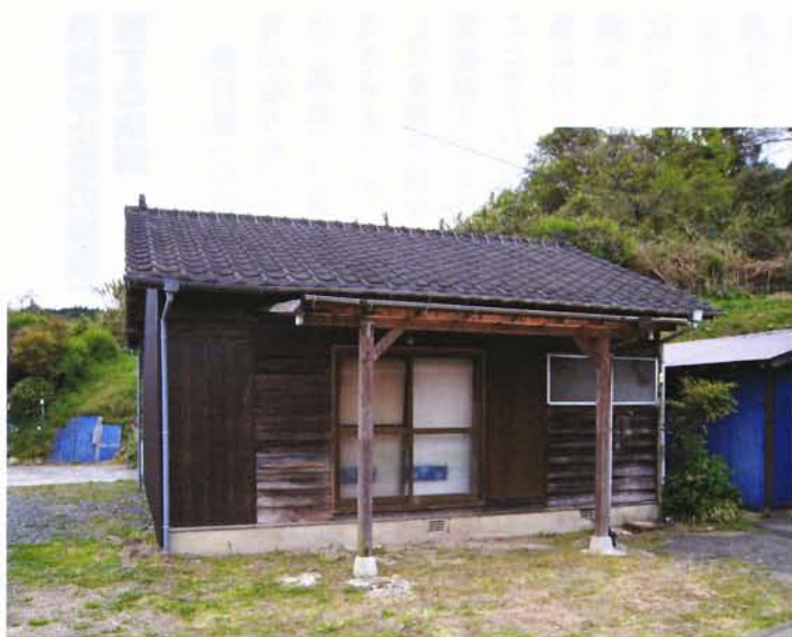
老朽化し除却する予定の市営住宅
