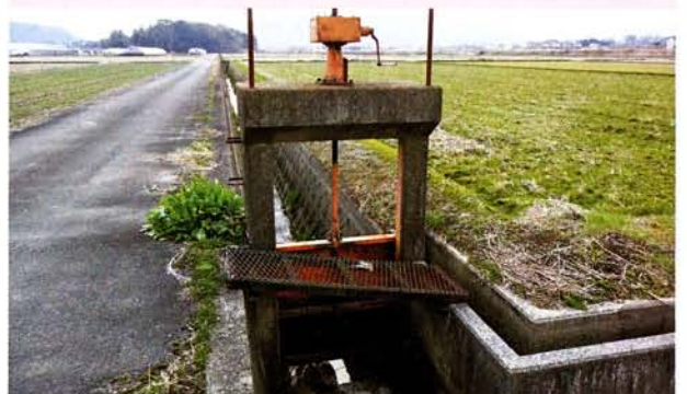
改修予定の農業施設(碓井地区)
