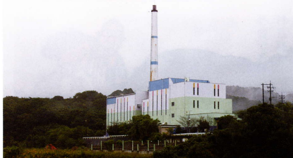
維持補修工事が行われる嘉麻クリーンセンター
