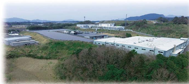
漆生工業団地
