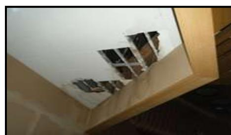
【嘉穂庁舎】建物加重による地下サッシ変形、開閉不可
