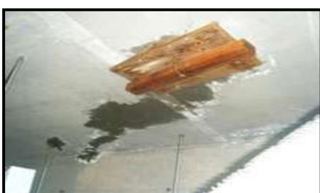
【山田庁舎】雨漏りのため天井破損
