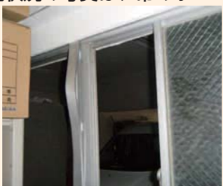
嘉穂庁舎：建物加重にて地下サッシ変形により開閉不可
