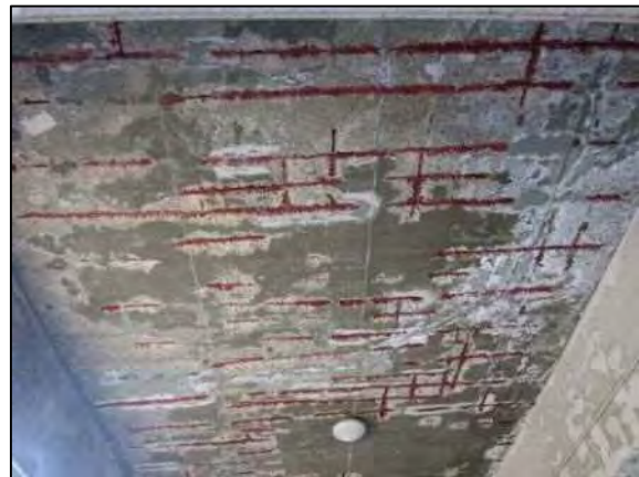
図 4-4. 高齢者介護課横天井剥離 (1階)
