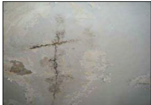
図 4-9. 3階 屋上出口階段
