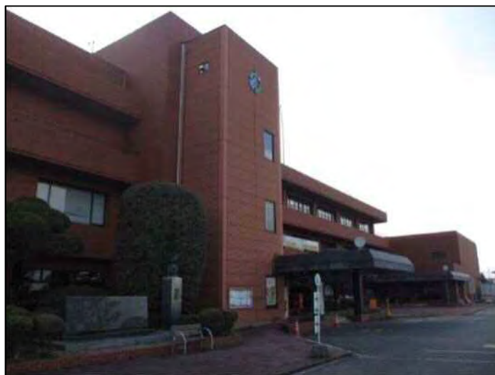
図 4-12. 碓井庁舎本館
