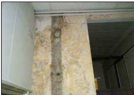
図 4-8. 1階 壁雨漏り剥離
