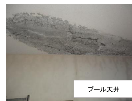
梁根元の亀裂
