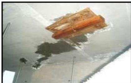
【山田庁舎】雨漏りのため天井破損
