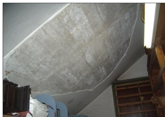
写真 5 1 F 階段下倉庫
