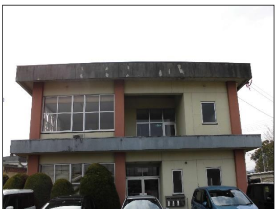
写真11 ⑤ 稲築庁舎別館4
