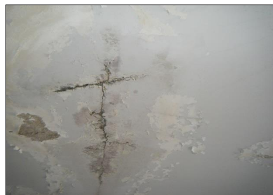
写真 4 3 F 屋上出口階段
