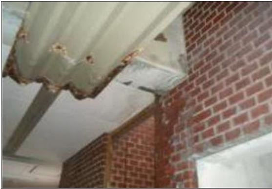
写真2 雨漏りによる天井、外壁劣化剥離箇所
