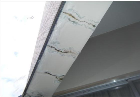
写真4 2F書庫奥部屋雨漏り壁亀裂・剥離
