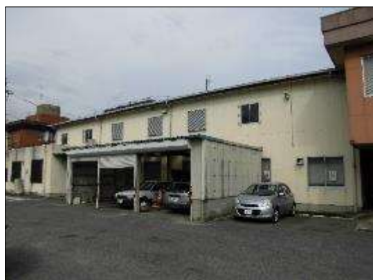
写真 9 ③ 稲築庁舎別館 2
