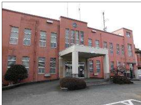
写真 7 ① 稲築庁舎本館
