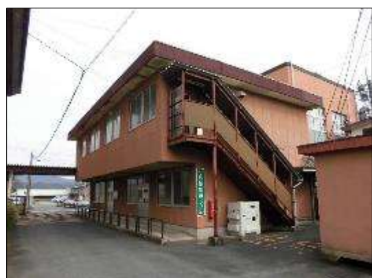
写真 10 ④ 稲築庁舎別館 3
