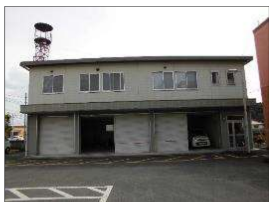
写真 12 ⑥ 庁舎本館前
