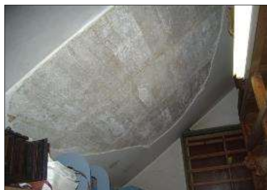
写真5 1F 階段下倉庫
