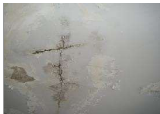
写真4 3F 屋上出口階段
