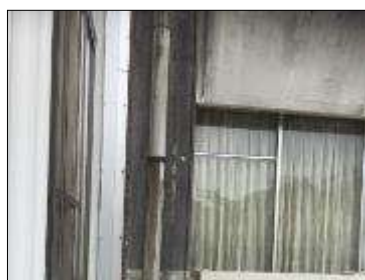
写真 37 庁舎との接合部分
