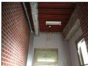
写真 36 2 階庁舎からの入口付近
