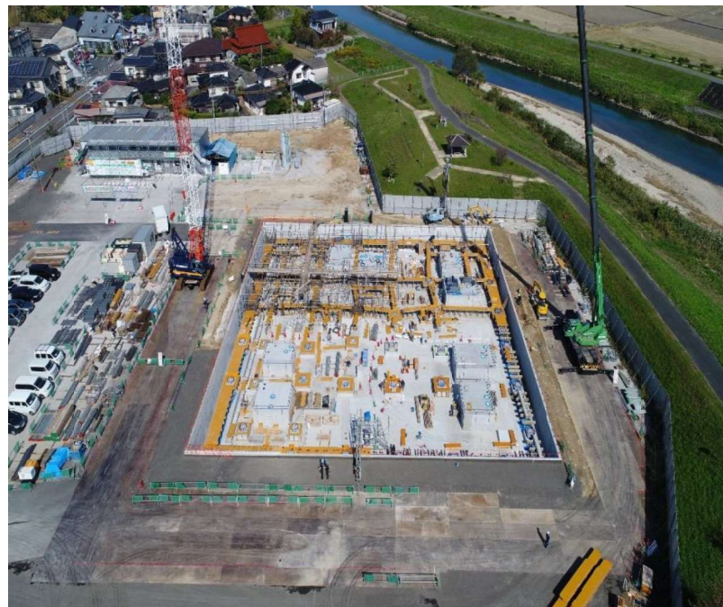
新庁舎南側工事進捗状況
