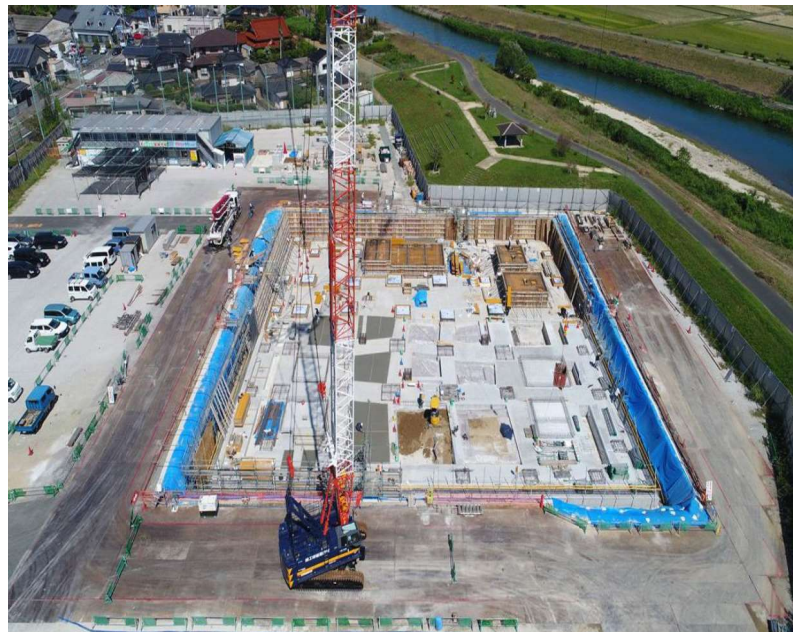
新庁舎南側工事進捗状況
