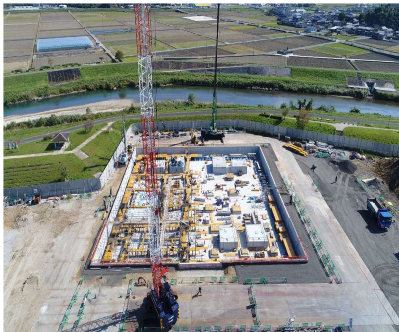
新庁舎西側工事進捗状況
