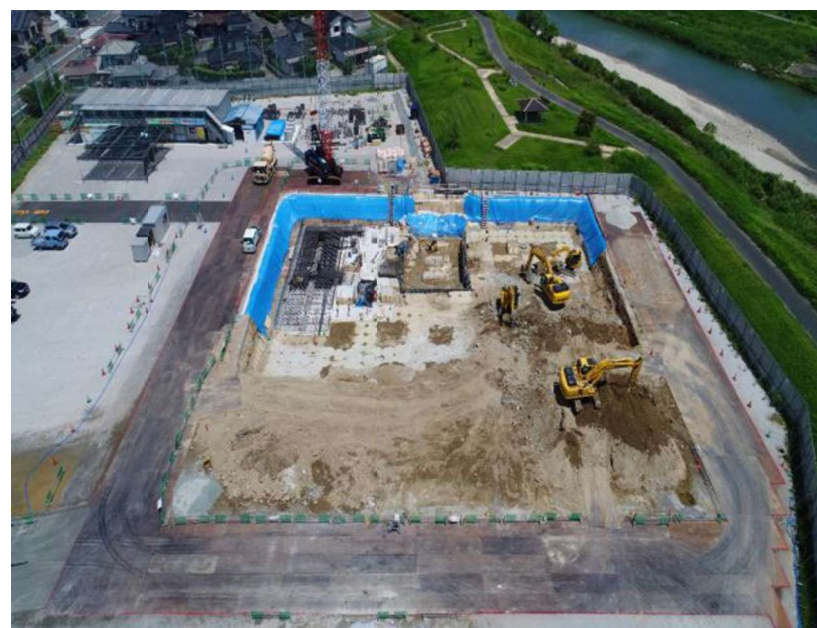
新庁舎南側工事進捗状況
