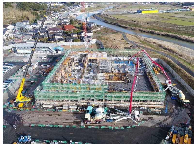
新庁舎南側工事進捗状況
