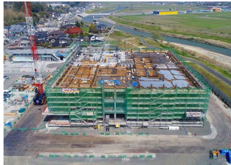
新庁舎南側工事進捗状況
