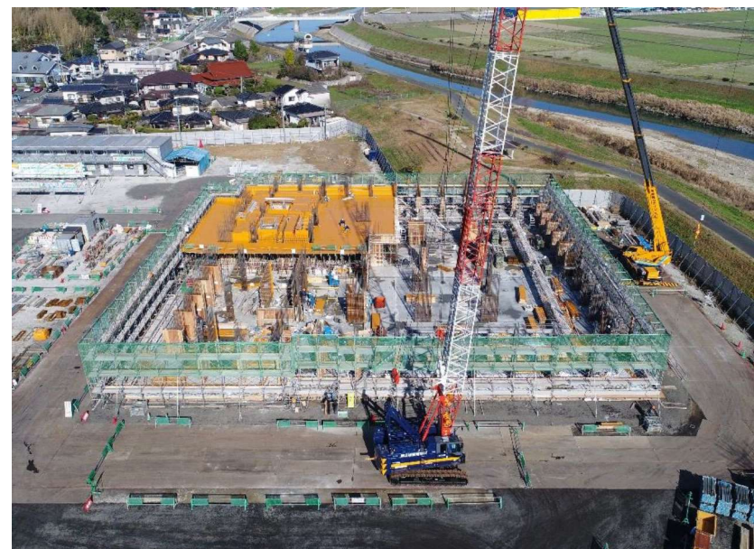
新庁舎南側工事進捗状況
