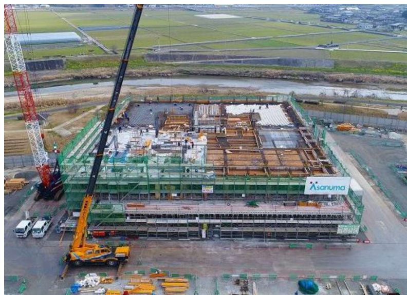
新庁舎西側工事進捗状況
