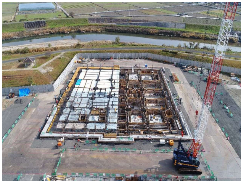
新庁舎西側工事進捗状況
