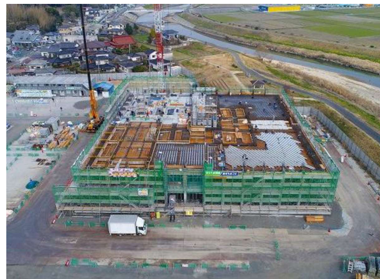
新庁舎南側工事進捗状況
