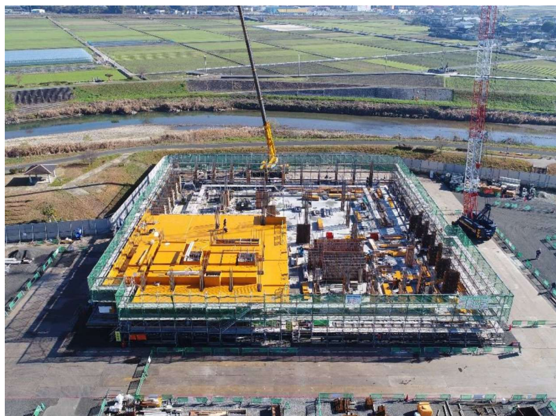
新庁舎西側工事進捗状況
