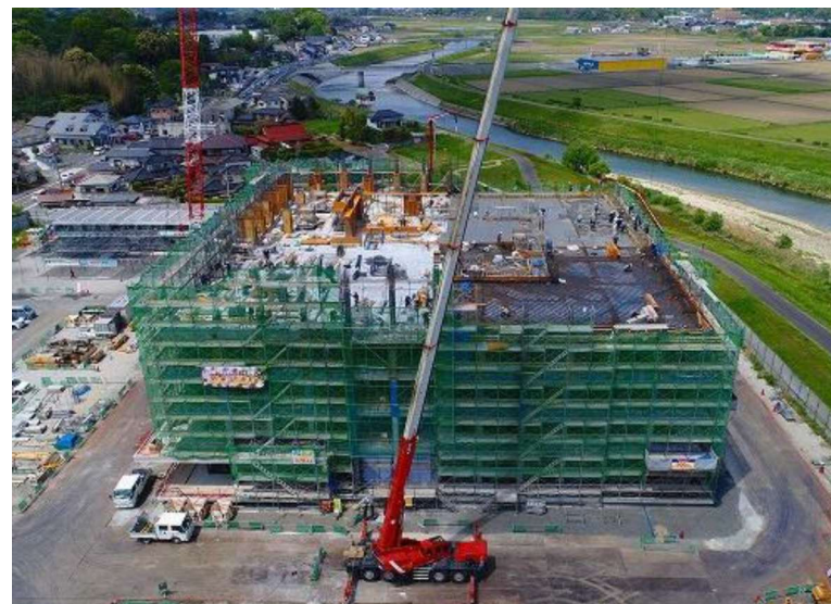
新庁舎南側工事進捗状況
