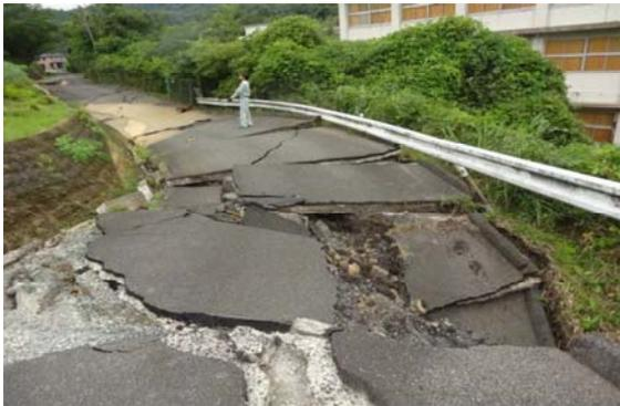
写真 23 市道の崩壊
