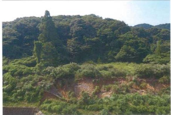
写真 22 法面の崩落
