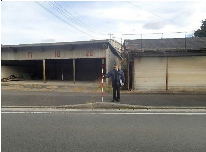
鴨生団地下 下り正面
