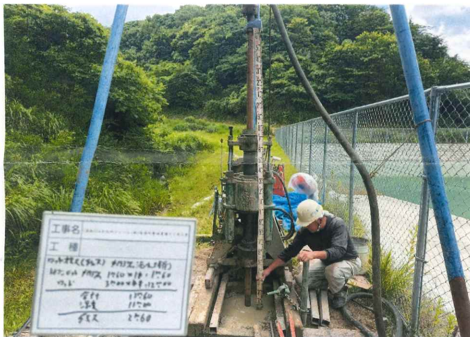
ボーリング掘削状況写真
