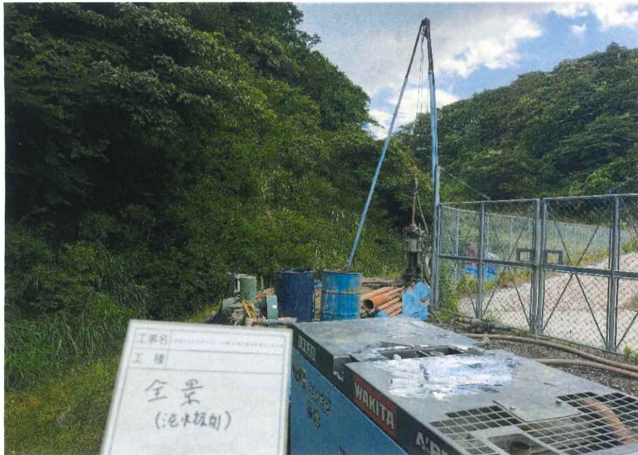
ボーリング掘削状況写真
