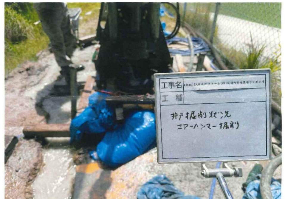
エアハンマー掘削状況写真
