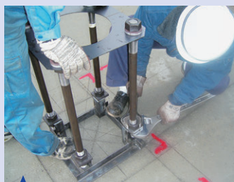
ISベース(作業風景)
