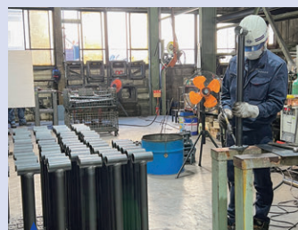
鉄工事業部(作業風景)
