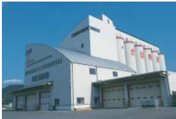
カントリーエレベーター
