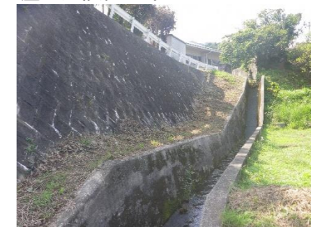
⑥ 西側間知石積の擁壁
