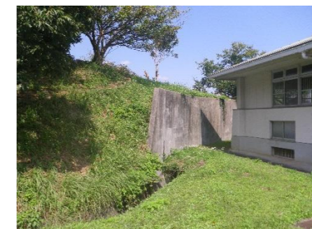
⑧ 北側柔道道場と隣地高台のコンクリート擁壁
