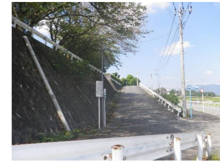
② 北側既存擁壁と桜並木
