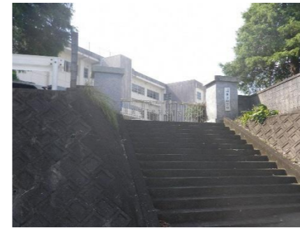
① 北側敷地内通路 正門にアプローチする階段
