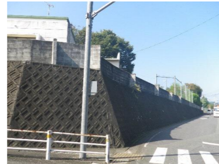
⑤ 北東側既存擁壁上のブロック壁
