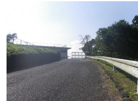
② 駐車場へ北側敷地内通路車両入口
