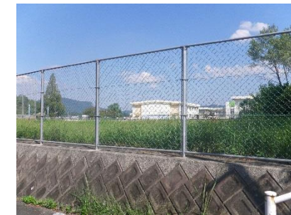
④ 南西側角既存擁壁、高低差 1m 程度 入口を新設可能な高さ
