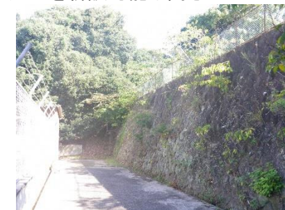
⑥ 南側プールに隣接する間知石積擁壁
