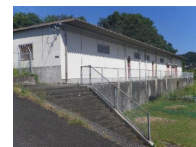
⑦ 北側プールと更衣室 グラウンドと2m程度の高低差
