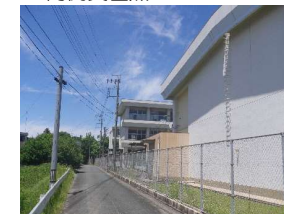
④ 西側道路と住宅地側ガードレール。ネットフェンスと稲築東中学校が見える
