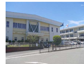
① 正門の明るいアプローチと体育館
